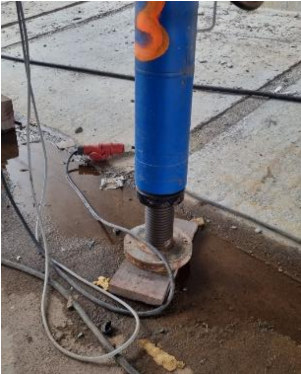
Foto 11 Vijzel waarmee tunnelbekisting op hoogte wordt gesteld
