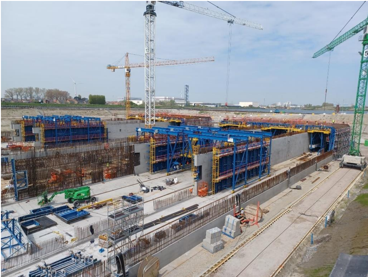
Foto 7 Twee portaalbekistingen voor de drie middenwanden (bron: Gerard van Daatselaar)
