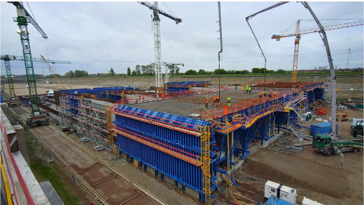
Foto 12 Tafel/halftunnelbekistingen met aan een zijde de sluitkisten (bron: Gerard van Daatselaar)
