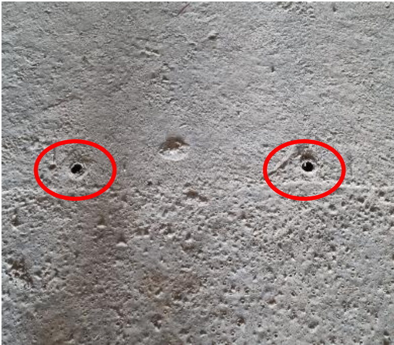
Foto 13 Voorziengingen (gaatjes) voor het achteraf doorslijpen van de langsnaspanning
