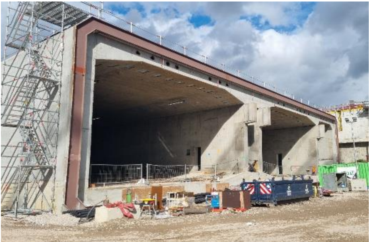
Foto 15 Elementen met zinkvloegomranding aan de kopse zijde
